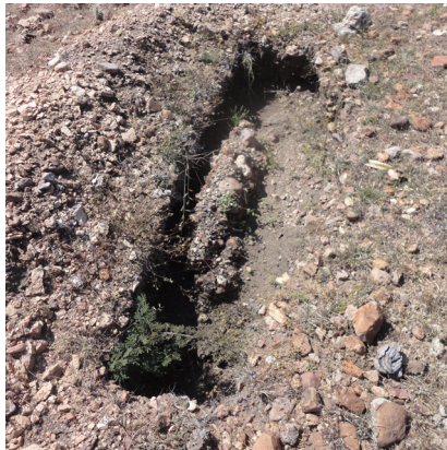
Foto 7,8,9. Bordos desnudos, taludes caídos y socavados
