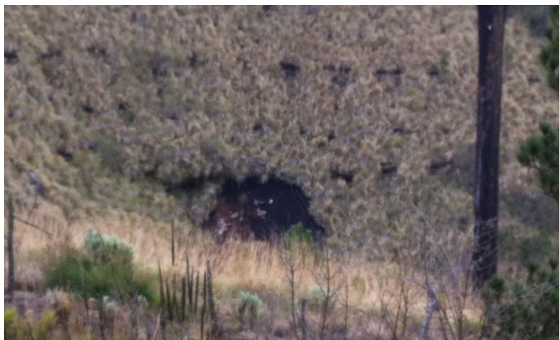
Foto 1. Cárcava formada a partir del talud de la zanja
