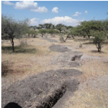
Foto 7,8,9. Bordos desnudos, taludes caídos y socavados
