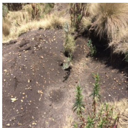
Foto 4,5,6. Taludes de zanjas desprendidos
